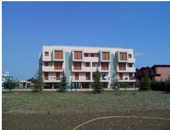
Figura 1: Vista frontale delle tre palazzine
