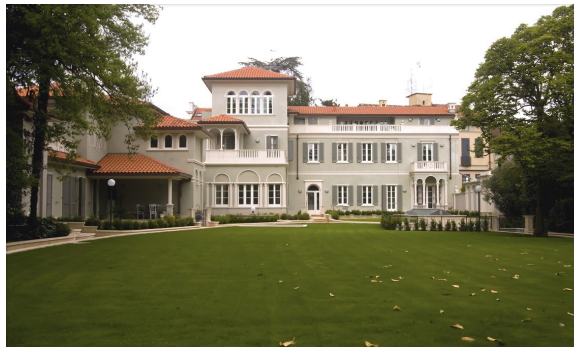
Figura 4: parco del residence; le sonde geotermiche verticali sono installate sotto i garages.
